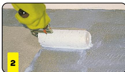
**2. Superficies Nuevas:** aplicar 1 mano de **tacurú fijador sellador al agua** siguiendo las instrucciones de este producto. En caso de imperfecciones menores repararlas mediante el uso de **tacurú enduido plástico**. Imprimir nuevamente, lijar hasta emparejar la superficie.
